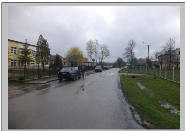
Zdjęcie nr 1. (krótka infor.) Przejście dla pieszych na drodze powiatowej 4413W w m. Wola Mystkowska przy szkole podstawowej i boisku.
