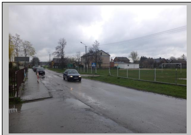
Zdjęcie nr 4. (krótka infor.) Przejście dla pieszych na drodze powiatowej 4413W w m. Wola Mystkowska przy szkole podstawowej i boisku.
